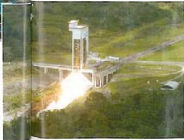
Le P80 sur son banc de tir. Il a délivré une poussée moyenne de 190 tonnes pendant 100 secondes (en médaillon).
